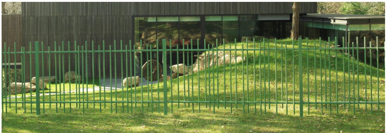
Clôture barreaudée avec espace libre au pied (source : Alloclosure.com )
