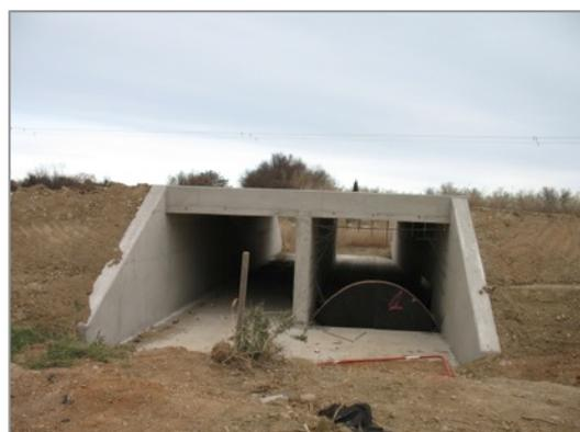
Passage sous route et hors d'eau, peu favorable mais potentiellement utilisable par la faune terrestre, et nouveaux passages hydrauliques, de grande taille et remplaçant de petites buses, mis en place sous la RD81.
